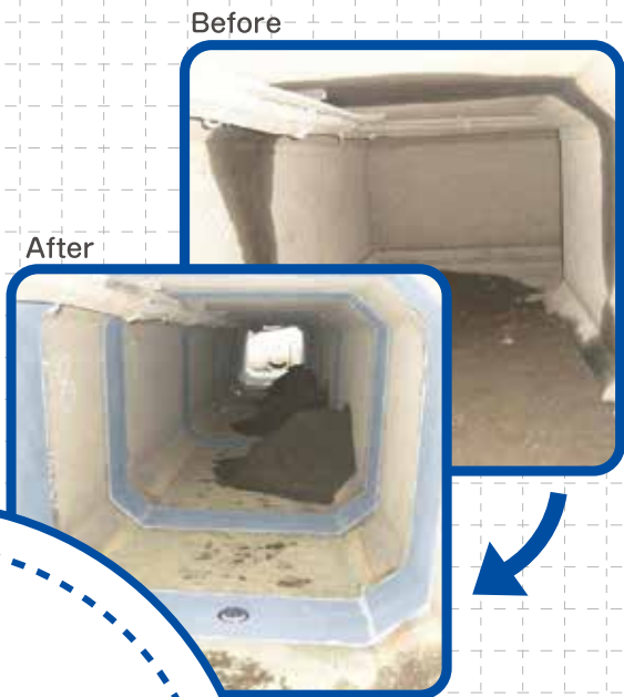
用水路ボックス目地補修工事 (処理用ウィーブホール装着)
