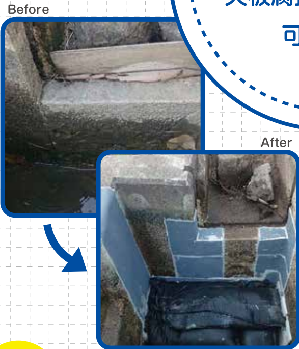
コンクリート柵補修工事
