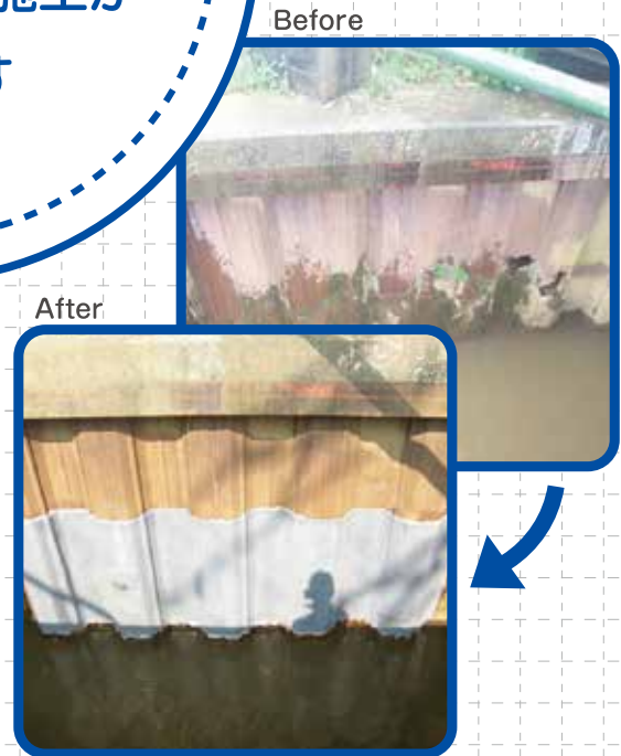
矢板排水路補修工事（陥没穴箇所補修）
