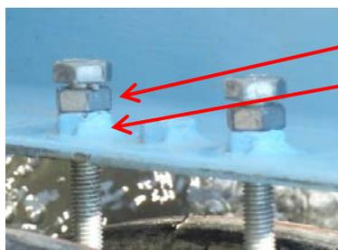
※固定が甘いと判断される場合、②のナットBにボルトを取り付け、既設管を貫通させて固定して下さい。
