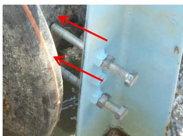
⑥付属のナットを固定枠ナットに締め込み、ボルトを固定します。
