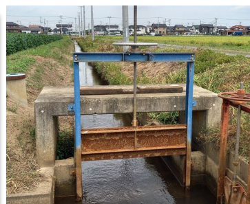
設置から約10年経過した鋼製ゲート
