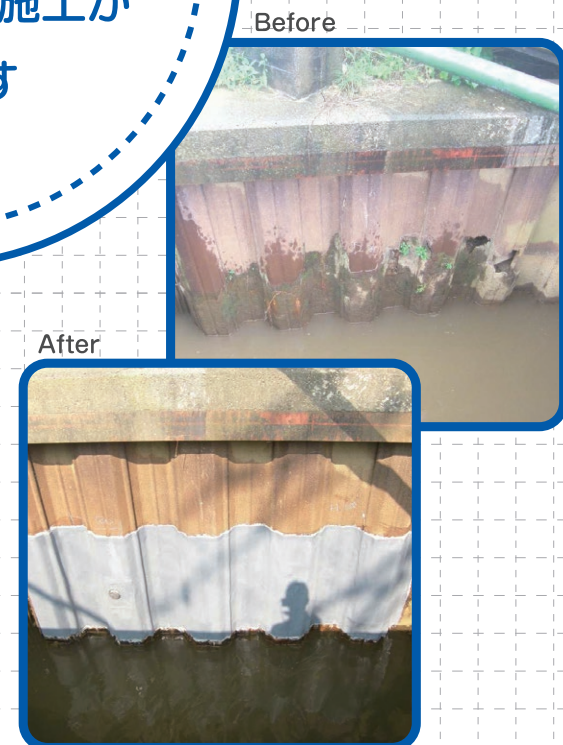
矢板排水路補修工事 (陥没穴箇所補修)
