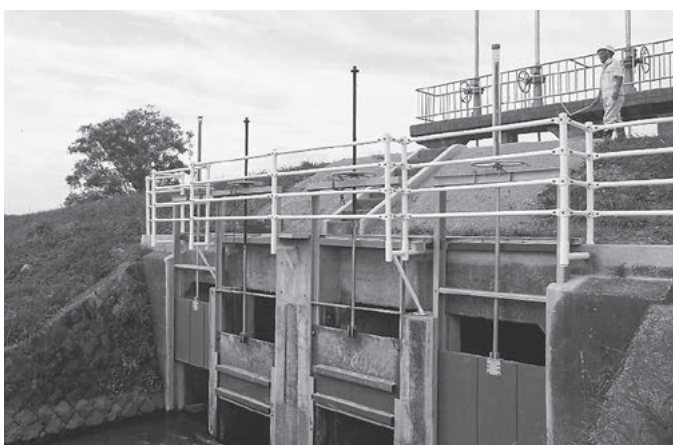
●既設ゲート取替
