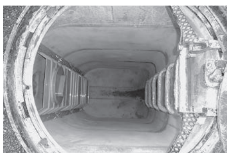
●A1マンホール
