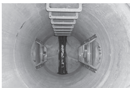
●2箇所付け施工
