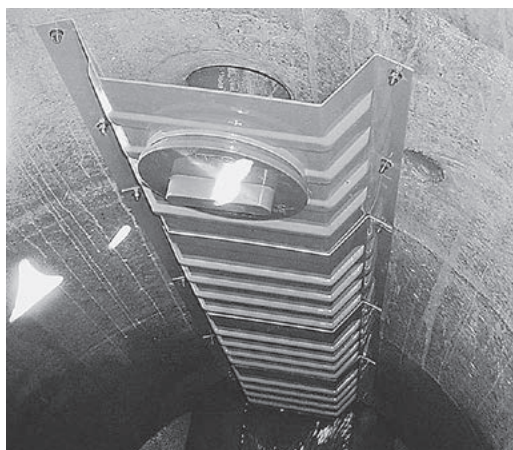
●2号マンホール
